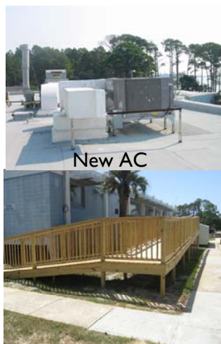
New ADA ramp
